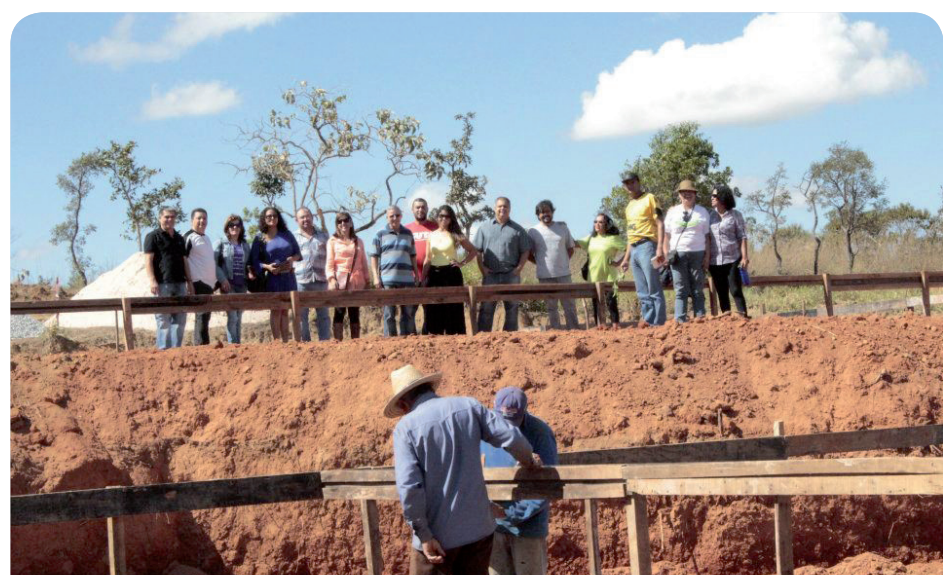
Diretores do Sinpro durante início da obra...
